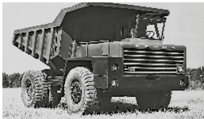
Введение в облицовку Г-образного буфера решало важный вопрос масштабирования при использовании унифицированной кабины на машинах разной грузоподъемности
